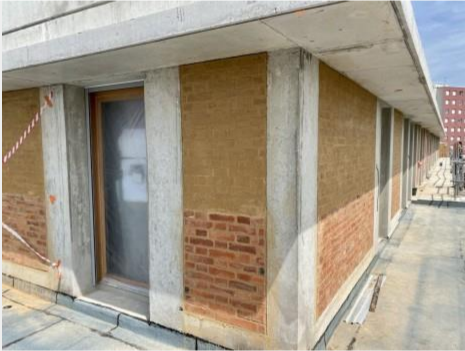
Une partie du mur est recouverte de briques en terre cuite pour protéger la terre crue de la pluie. © L-A Fournier
