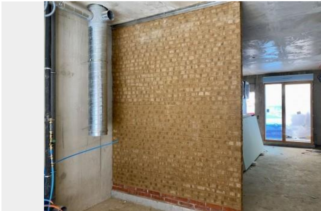
Une des cloisons en terre crue d'un appartement de la résidence. © L-A Fournier
